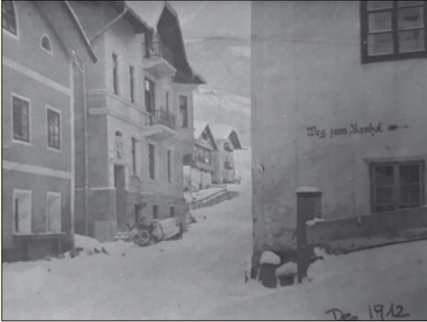
Der Rohbau ist fertig - 1912
