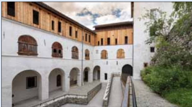
Restaurierter Innenhof der Burg mit Arkaden- und Laubengängen des Westtraktes aus dem 16. Jahrhundert.
