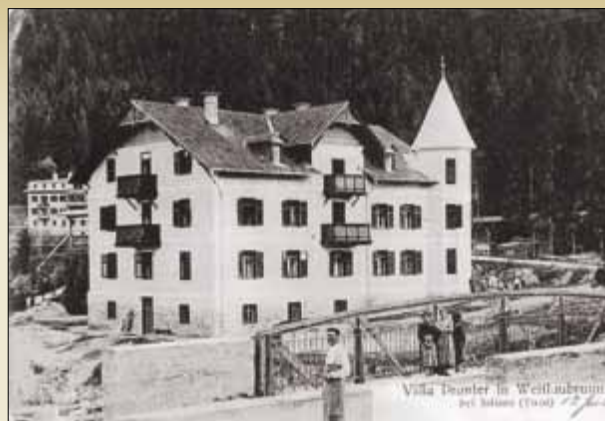
Villa Pranter ca. 1910 nach der Fertigstellung, Archiv Anton Walder
